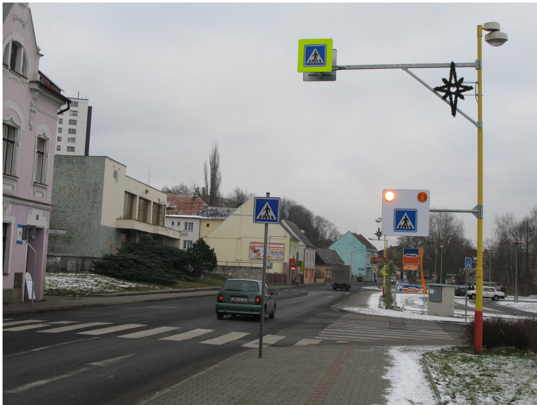
přechod pro chodce v Mímoní, ul. Husova, silnice č. II/268, u obchodního domu TESCO, ve směru Mnichovo Hradiště
