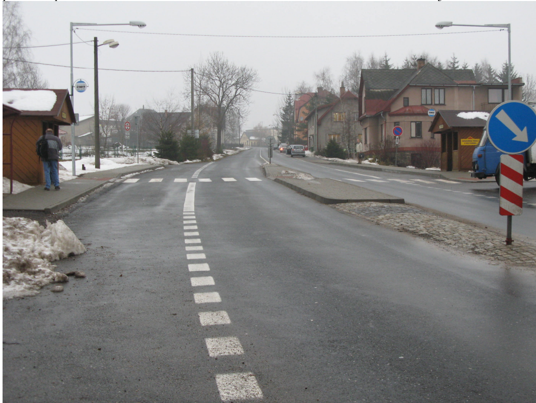
přechod pro chodce s dělicím ostrůvkem v Pěnčíně, silnice č. II/287, směr Jablonec nad Nisou
