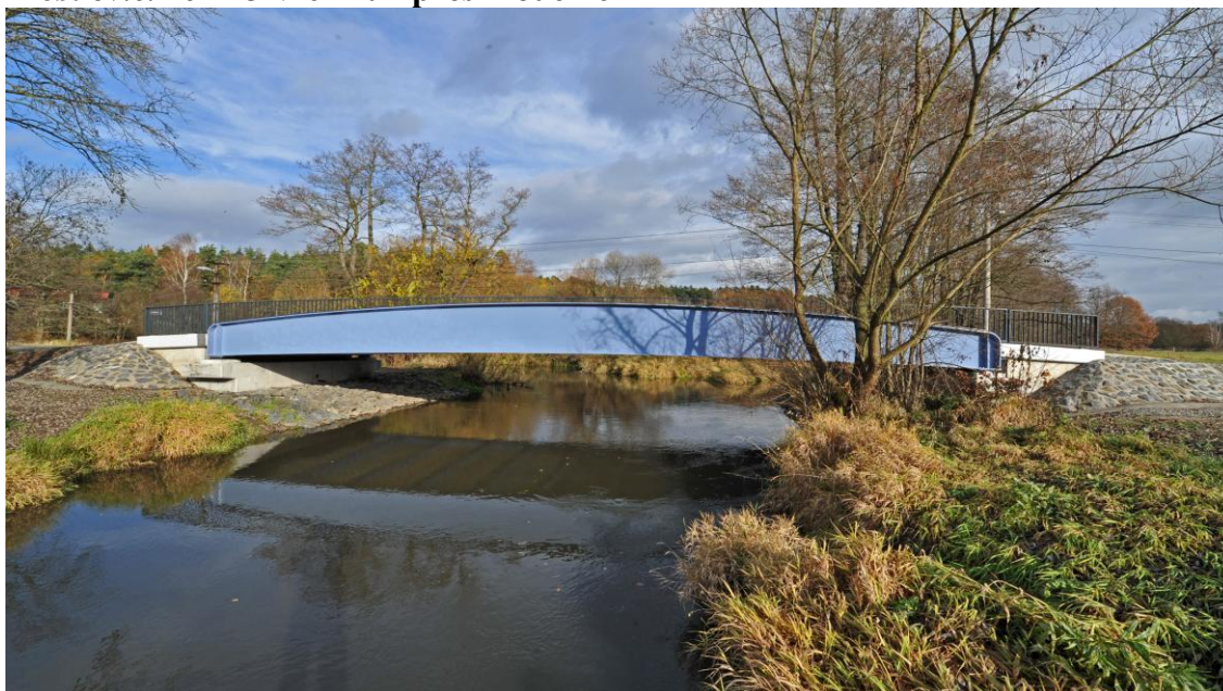
Most ev.č. 2621-3 Vlčí Důl přes Ploučnici
