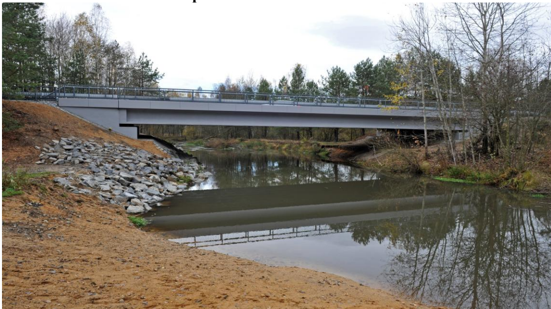
Most ev.č. 270-006 Boreček přes Ploučnici
