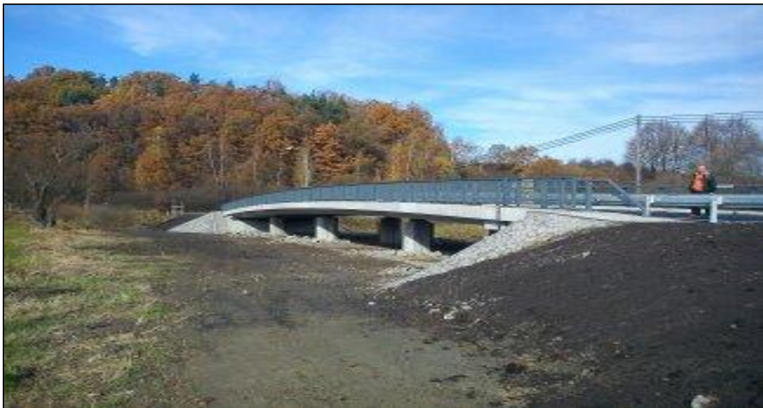
Most ev.č. 2623-2 Žizníkov přes zátopní území
