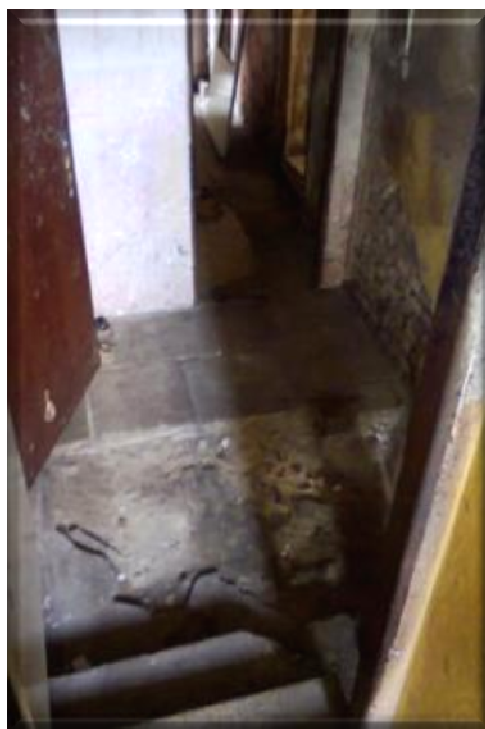
Prostory domu Mezivodí 592
