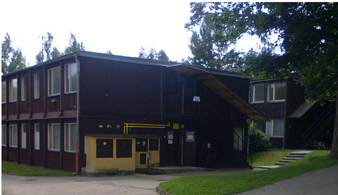
Ubytovna v Křižíkově ulici
