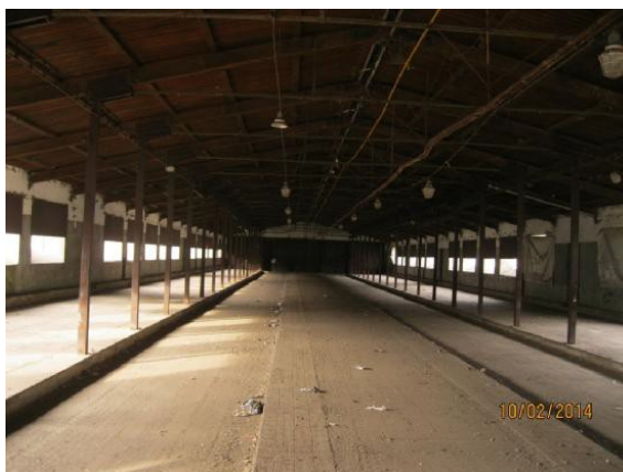
Foto č.8 – hala C – vyvezená hala
