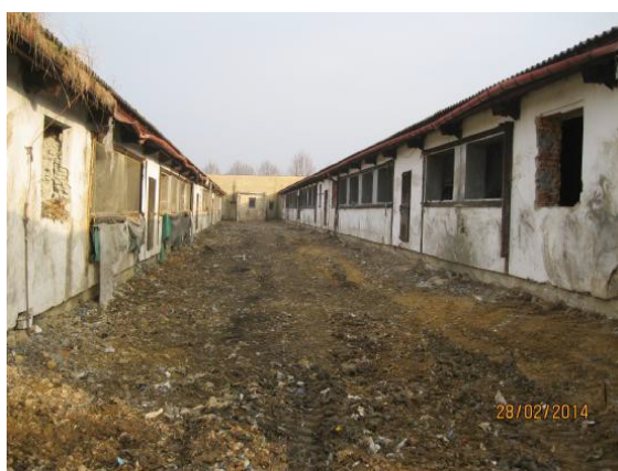
Foto č.6 - meziprostor C-D - vyčištěná plocha
