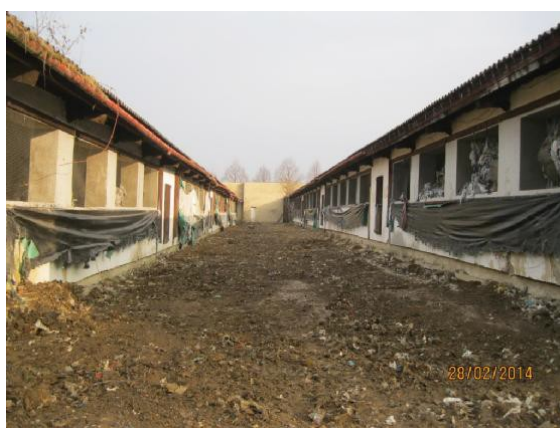
Foto č.4 - meziprostor B-C - vyčištěná plocha
