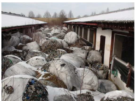
Foto č.5 - meziprostor C-D - původní stav
