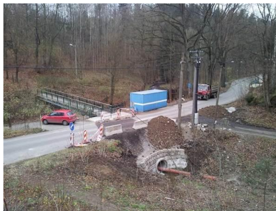
Propustek III/29021 Liberec, ulice Kateřinská – havárie a oprava propustku
