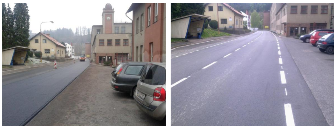
Silnice II/292 Pojizerka, Benešov u Semil – velkoplošná oprava, foto při realizaci a po dokončení
