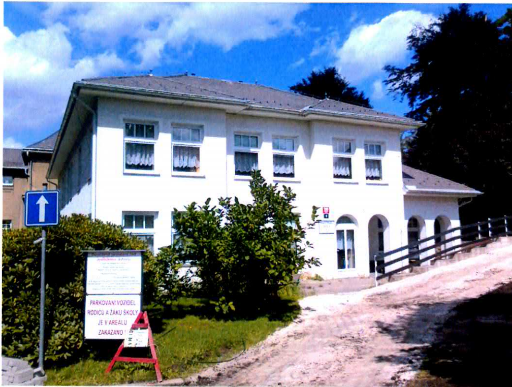
Přístupová cesta k hlavnímu vchodu do budovy Mateřské školy
