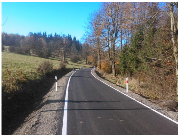
Silnice III/26318 od I/13 – Polevsko
