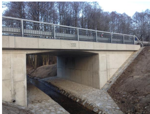
Most ev.č. 270-013 - přes potok u Postřelné
