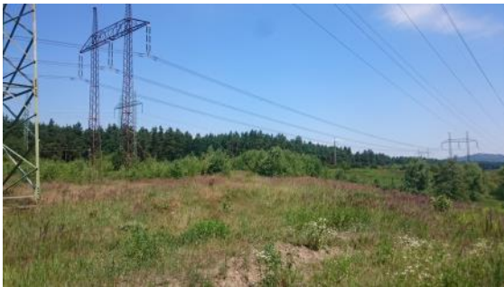
NÁSEP SE STOŽÁRY MIMO ŘEŠENOU PLOCHU
