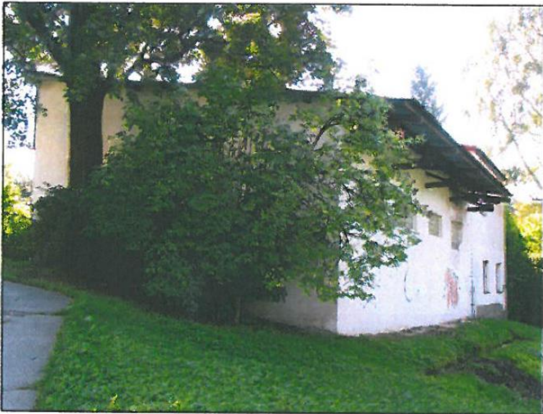
Pohled na garáže od SV
