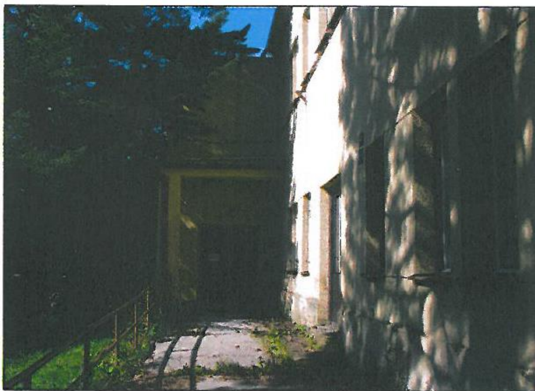
JZ stěna domu čp.118 a hlavní vchod přes přístavbu
