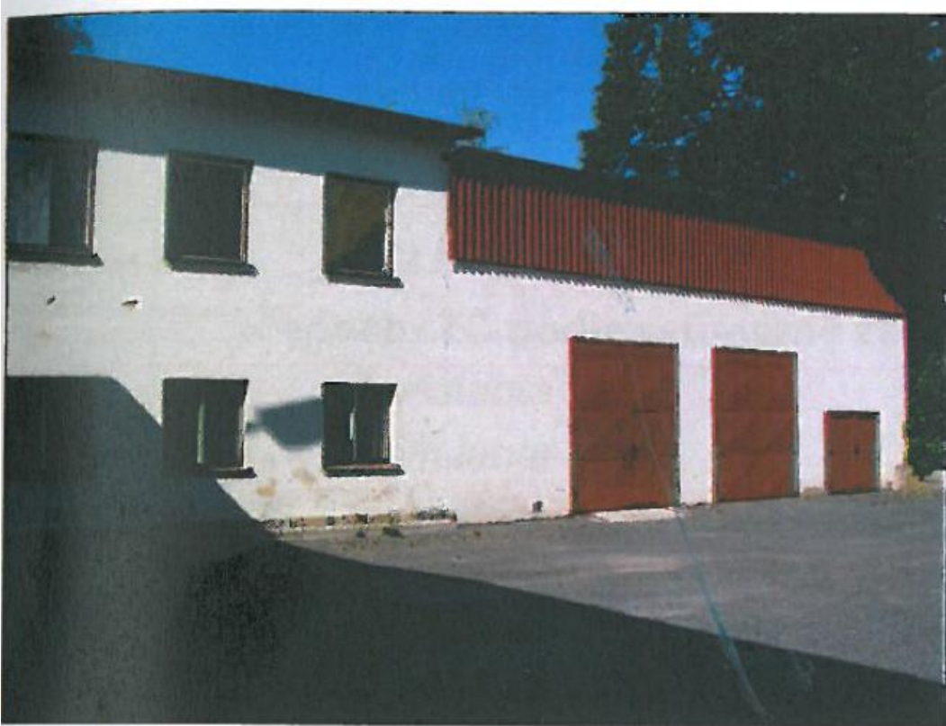
Pohled na SV část přístavby a garáže
