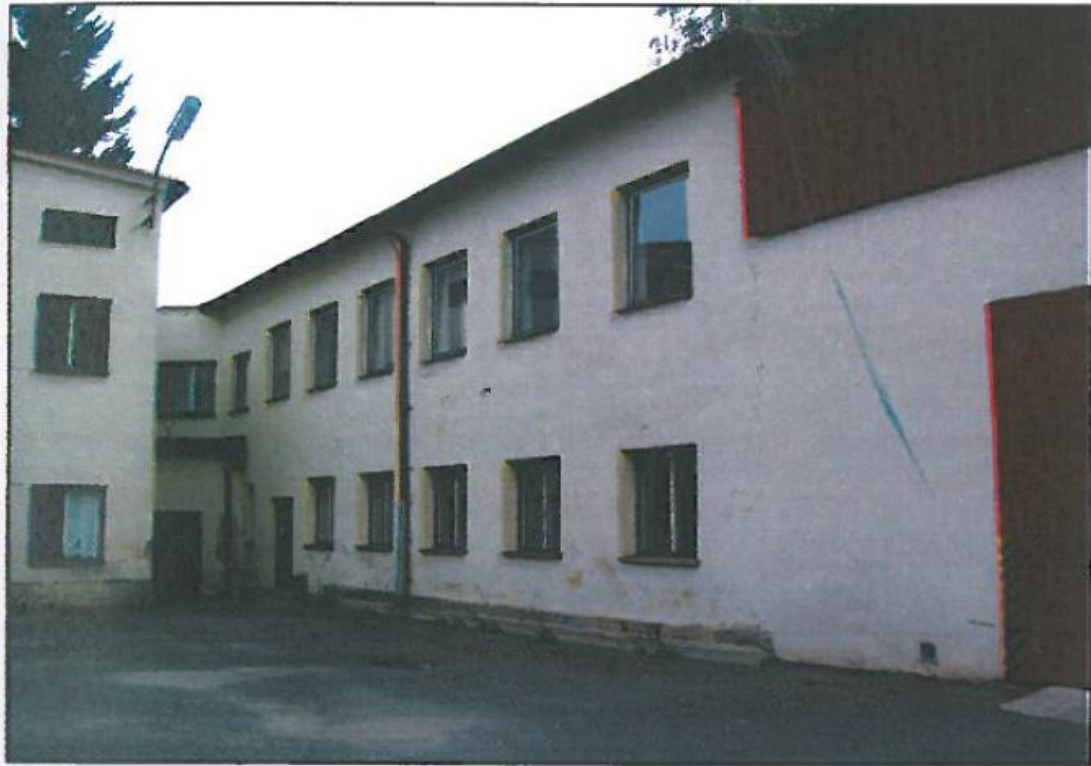
Pohled na přístavbu (s garážemi vpravo) od východu
