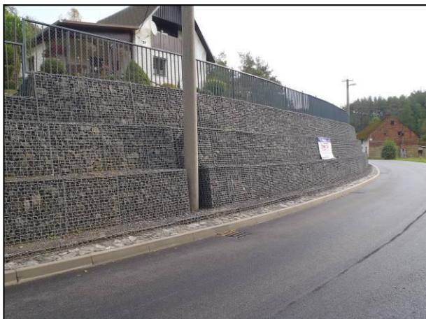
III/27244 Janovice v Podještědí, opěrná zeď
